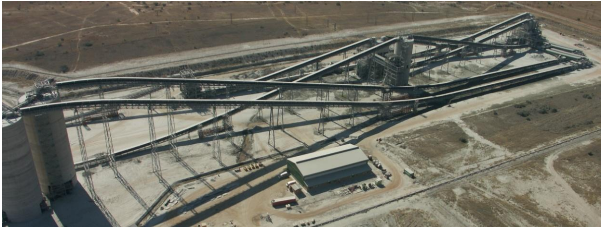
Figur 3. Torra krossprocessen för Mogalakwena North Concentrator (MNC). Krossarna är placerade till höger om mitten och siktarna är längst till höger.
